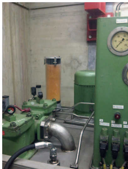
Edelstahl-Adsorber für aggressive Medien und Einsatz nach Atex 95.
